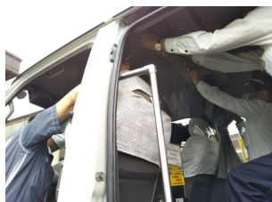
▲防染シート設置
